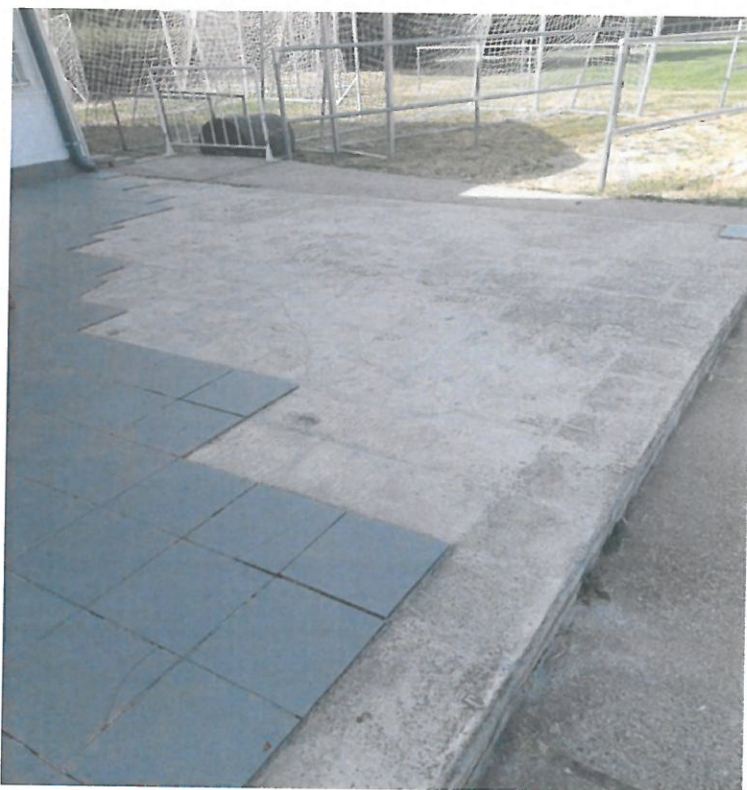
Bejárati terasz burkolata.
