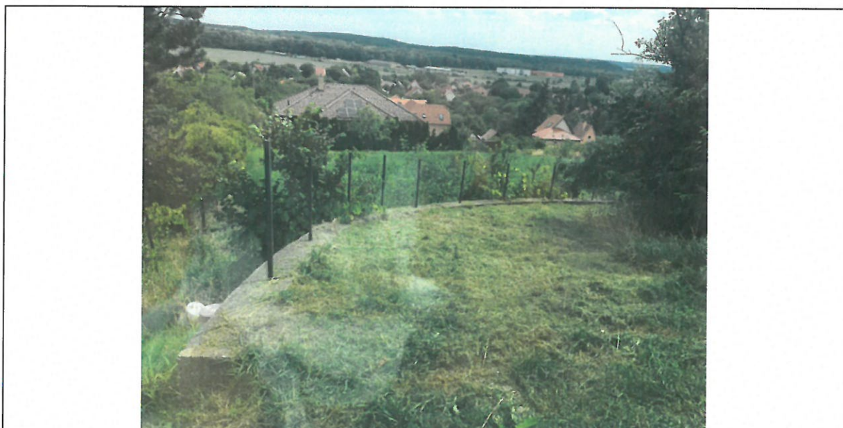
934/1 hrsz-ú ingatlanon megépített támfal
